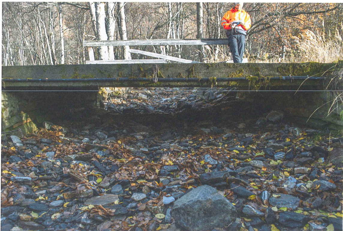
Figur 17: Bru sett mot NØ. Brua består av 1 stk solid betonghelle, som ligger løst oppå brukar bestående av steinheller.
