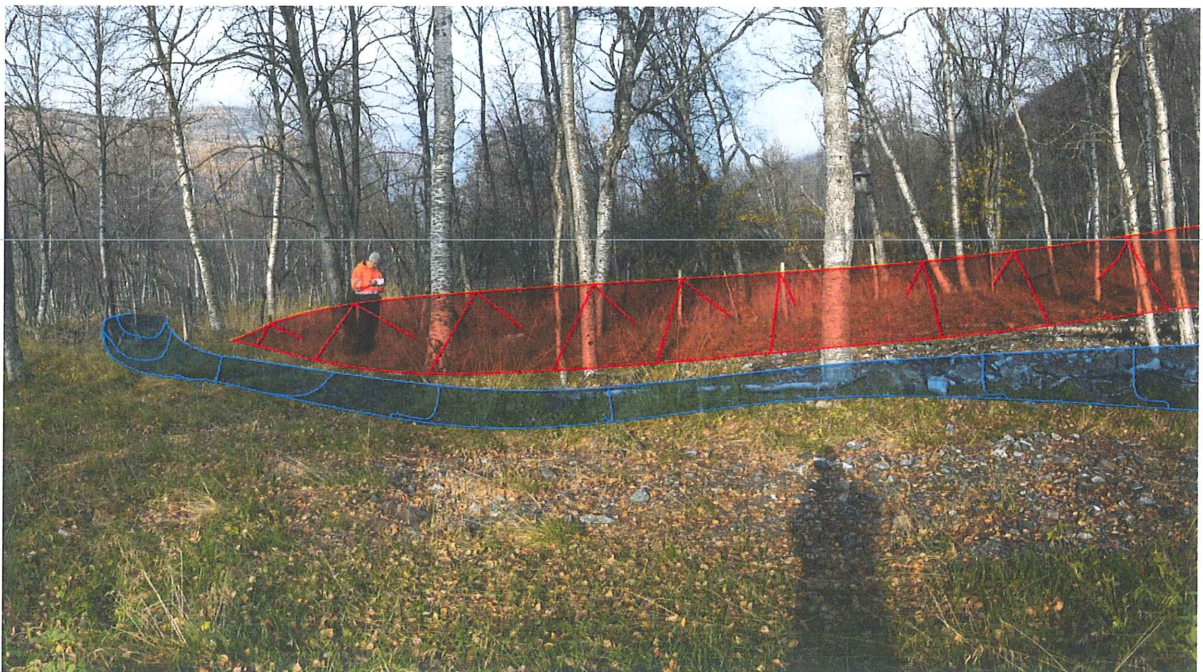
Figur 15: Vollen avsluttes i nedkant, mens dimensjonen på grøfta vil økes ytterligere der vollen avsluttes. Bildet er orientert mot VNV.
