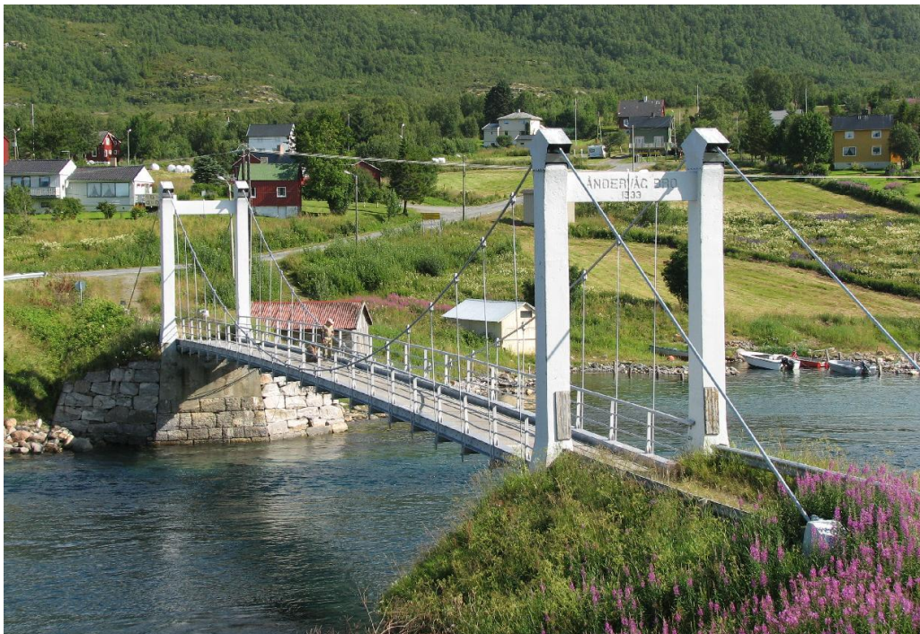
Åndervåg bro, Andørja, Ibestad kommune
