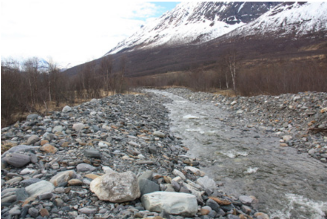
Bilde 7 - Grunneier har gjennom flere flommer sikret dyrka marka innenfor med steinmasser fra elva, flomfylling langs venstre side av elva.
