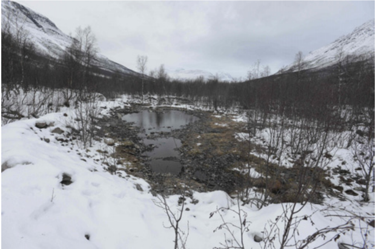
Bilde 10 - Flomløp, område for etablering av kulp ved tidligere masseuttak, sett nedover mot kulpen.
