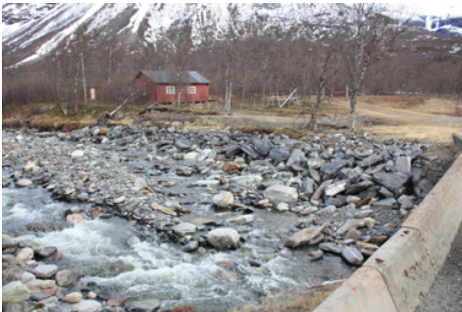
Bilde 4 – Reparasjon av erosjonssikring og opprydding inn mot brua, samle vannet i ett løp.
