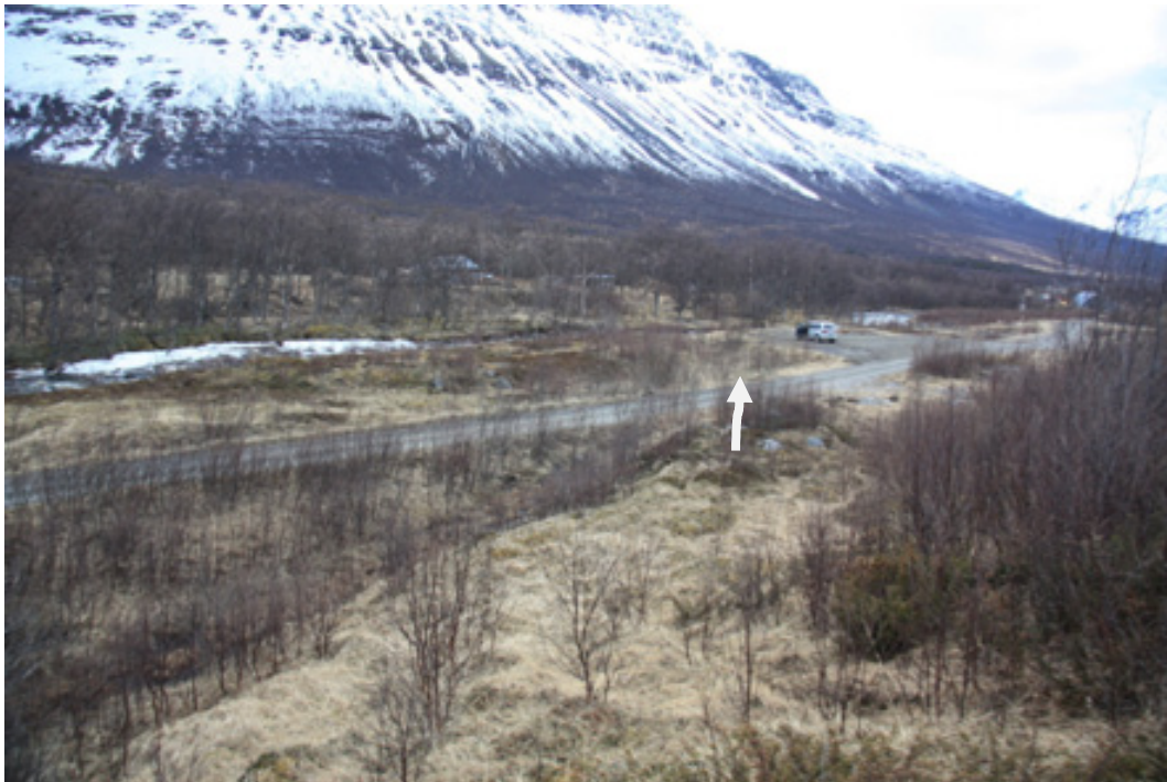
Bilde 2 - avskjæringsgrøft, fra veien ned mot elva
