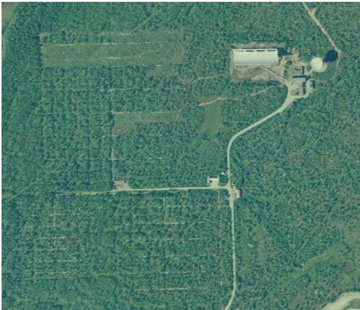
Oversikt over Eiscat-anlegget Ramfjorden. Heater-senderfeltene sees som rutemønster i skogen til venstre (Kilde: www.gulesider.no )
