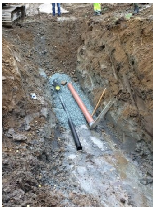
Arbeidet med å legge nytt VA-nett fra industriområdet på Oteren til Hansenskogen ble gjennomført i 2017.
