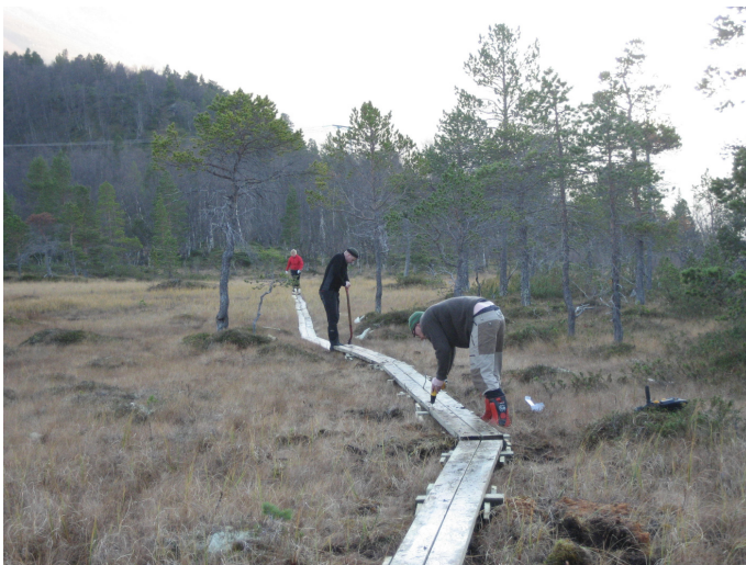
Anleggsutbygging med et mål for øye: Klopplugging av turstien mellom Bjørnhumpen og Skjellhumpen på Åsen.
